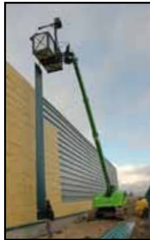
Montage von Wandelementen
